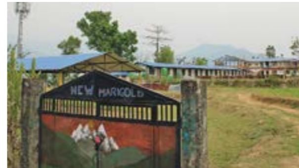
Die New Marigold-Schule wurde umfangreich saniert
